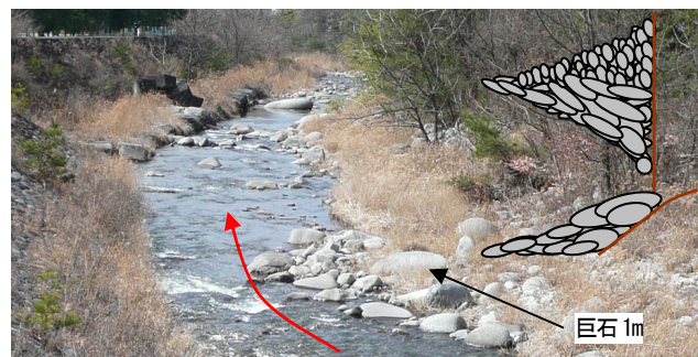
写真-1 笛吹川 琴川合流点直下流の自然形成型水制 (写真右上には同水制の平面図(上)と側面図(下)を挿入)
