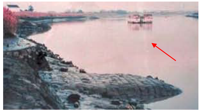
写真-4 筑後川 14.5k 左岸に現存する古い荒籠 1)
