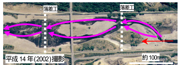
写真-2 大谷川の流路工(鬼怒川合流点付近)
