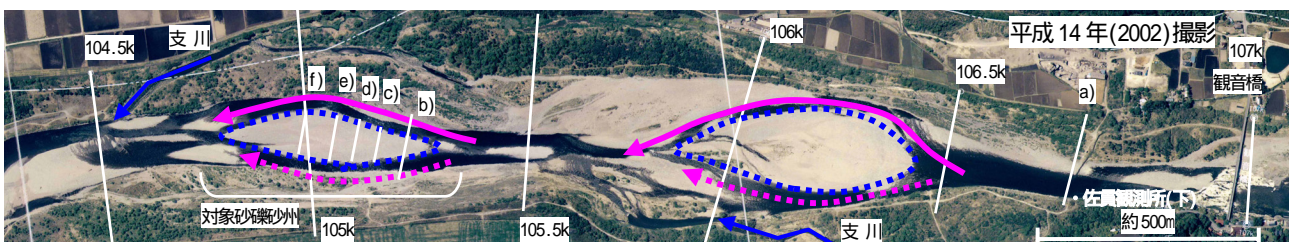
写真-1 砂礫砂州と2列蛇行の形成 [小林橋上流地区(104.5k~107k)]
